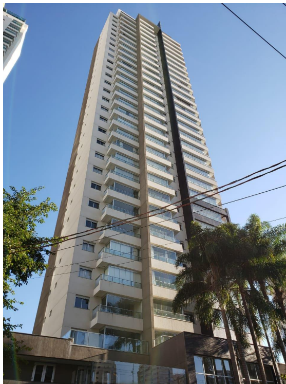
VISTA DA FACHADA DO EMPREENDIMENTO
